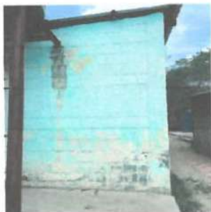
FOTO 1: PINTURA EN MUROS INTERIOR Y EXTERIOR
