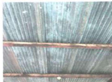
FOTO 2: ESTRUCTURA DE TECHO
