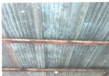
FOTO 3: CUBIERTA DE LAMINA
